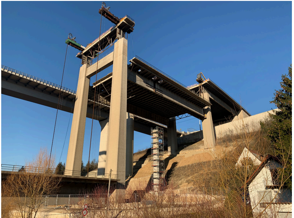
Abbruch und Aufbau: Alte und neue Heidingsfelder Talbrücke.
